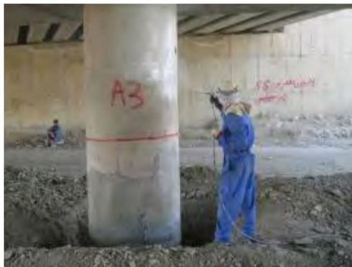
شکل ۶: اعمال لایه سطحی محافظ بر ستون تعمیری
